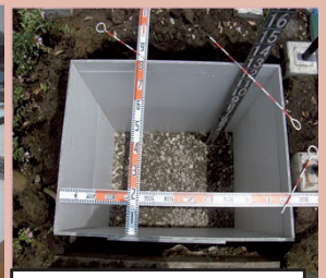
道路標識・街路灯 埋設型枠
