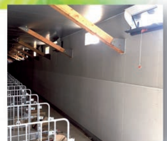
ハイブリッド施工例 (豚舎)
