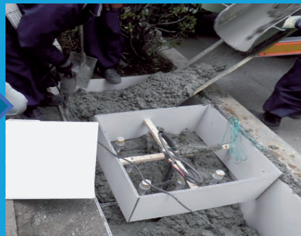
②コンクリート打設
