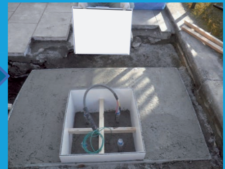
③アンカー設置
