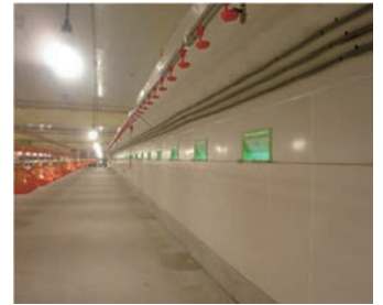
壁・天井施工例 (鶏舎)
