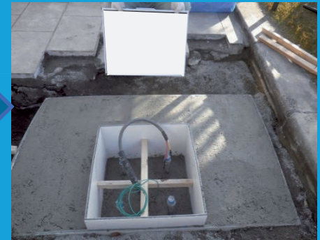
③アンカー設置
