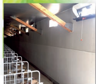
ハイブリッド施工例 (豚舎)
