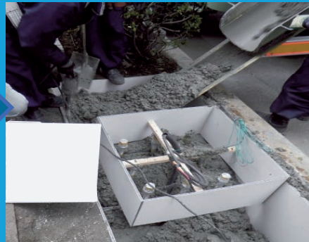
②コンクリート打設
