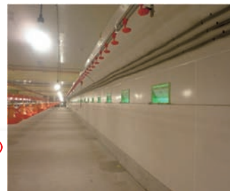
壁・天井施工例 (鶏舎)
