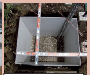
道路標識・街路灯 埋設型枠
