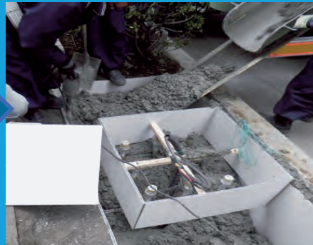
②コンクリート打設
