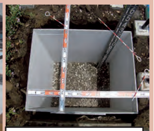
道路標識・街路灯 埋設型枠
