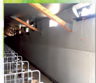
ハイブリッド施工例 (豚舎)
