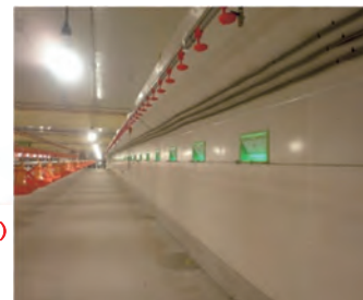
壁・天井施工例 (鶏舎)
