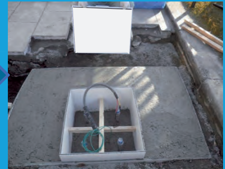
③アンカー設置
