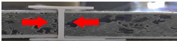
冬季に向け気温は低下しますので、突合せ気味で施工することをおすすめいたします。
