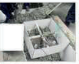
埋設型枠用途 (コンクリート打設)
