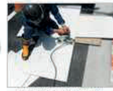
埋設型枠用途 (切断)
