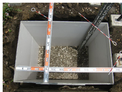
道路標識 埋設型枠
