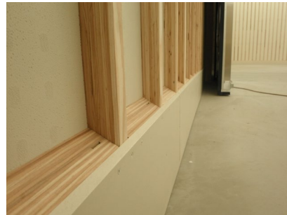
お米保管庫 内壁
